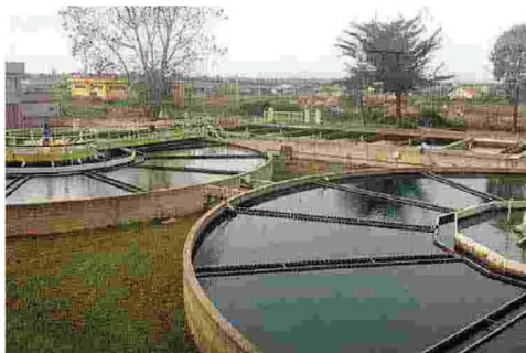
Uno degli impianti di potabilizzazione gestiti da Abbanoa
