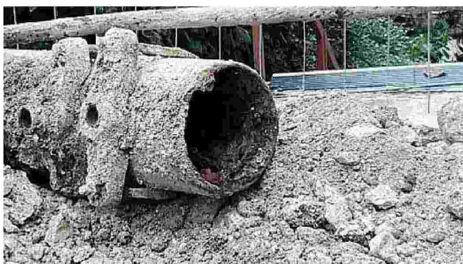
Una vecchia condotta idrica recentemente sostituita a Sassari
