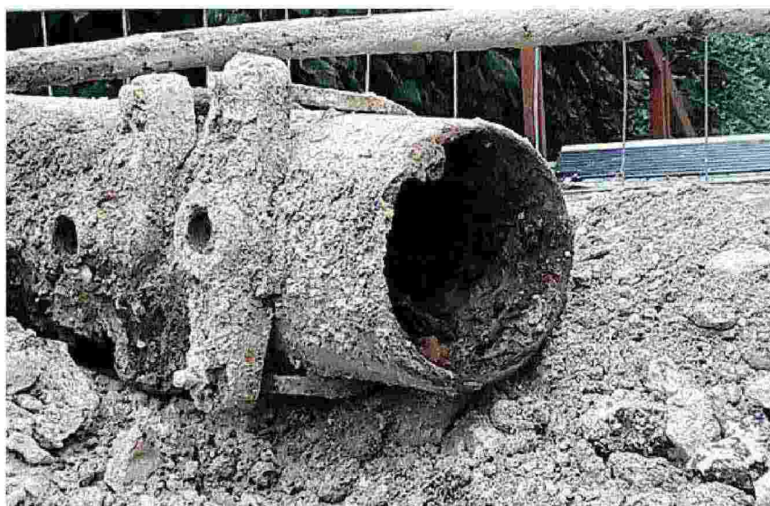
Una condotta idrica sostituita a Sassari
