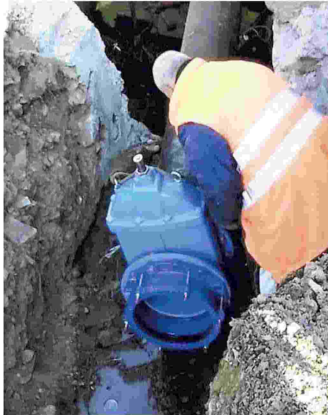
Un tecnico di Abbanoa impegnato in una verifica nella condotta a Sassari
