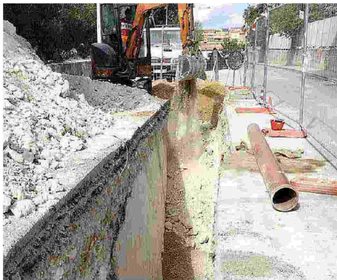
Lavori di Abbanoa a Li Punti
