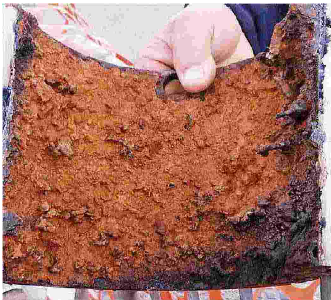
Un pezzo di una vecchia condotta idrica
