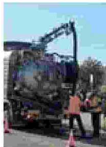
I lavori a S'Archittu
