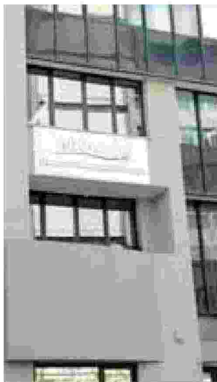
La sede di Abbanoa a Cagliari
