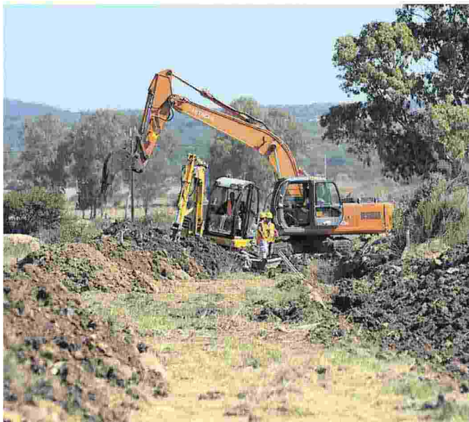
Lavori di Abbanoa per l'acquedotto
