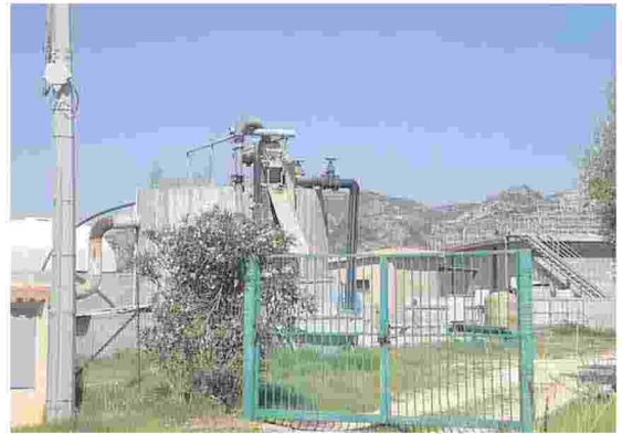
Il depuratore di Sos Alinos
