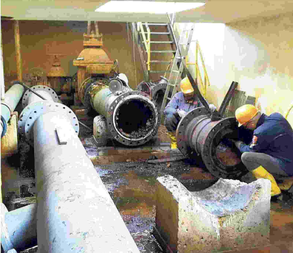
Operai alle prese con la sostituzione di condotte degradate
