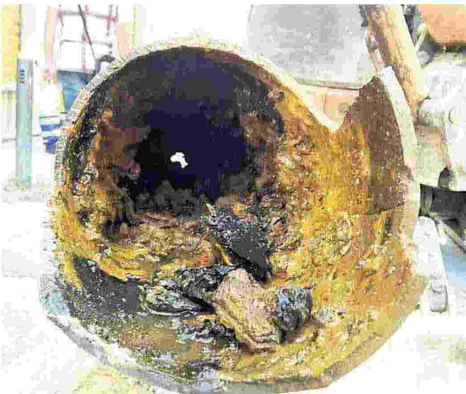
Una delle condotte sostituite in via Principessa Jolanda
