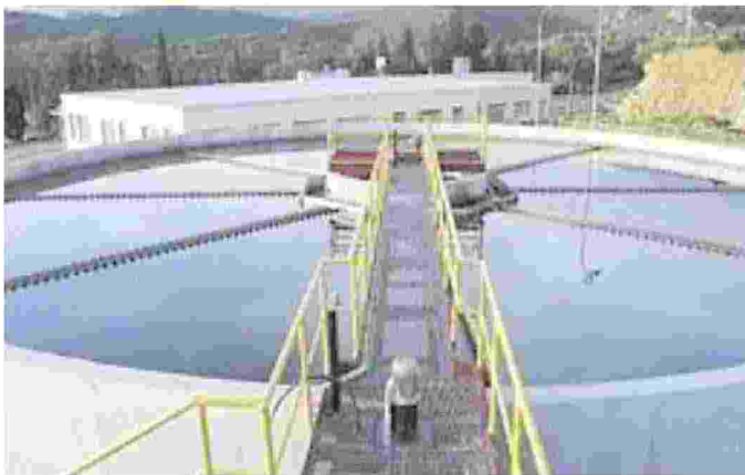
Un impianto di depurazione
