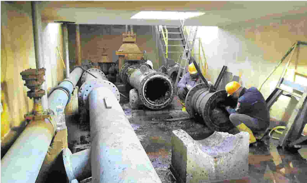
La sostituzione di una condotta danneggiata nella rete idrica di Sassari. A sinistra Alessandro Ramazzotti numero uno di Abbanoa
