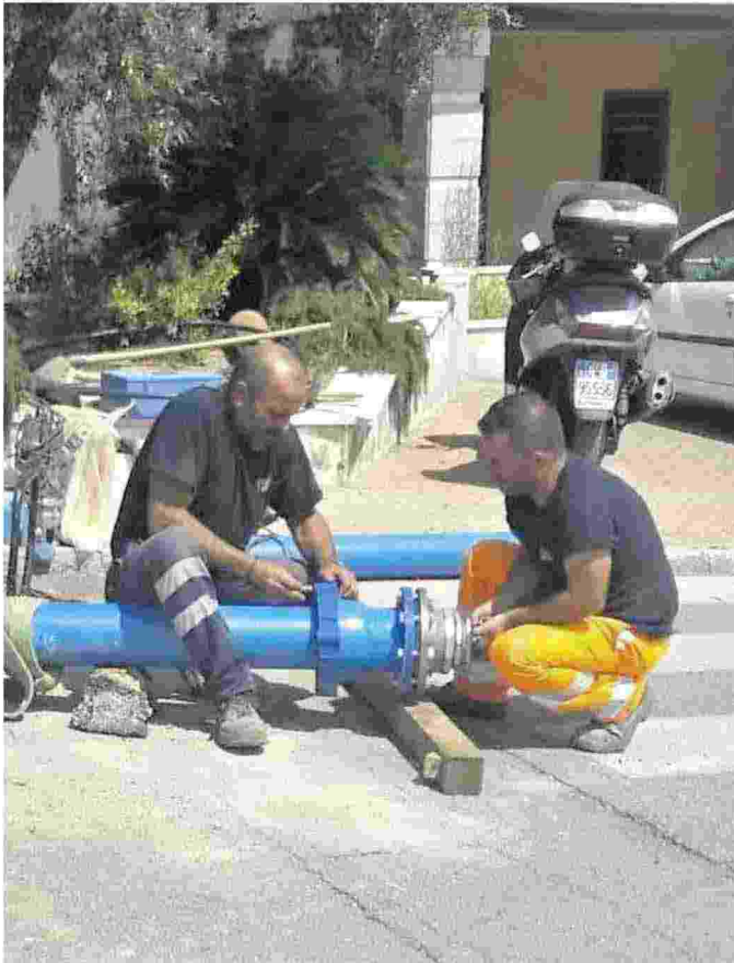
I tecnici di Abbanoa mentre riparano una condotta idrica
