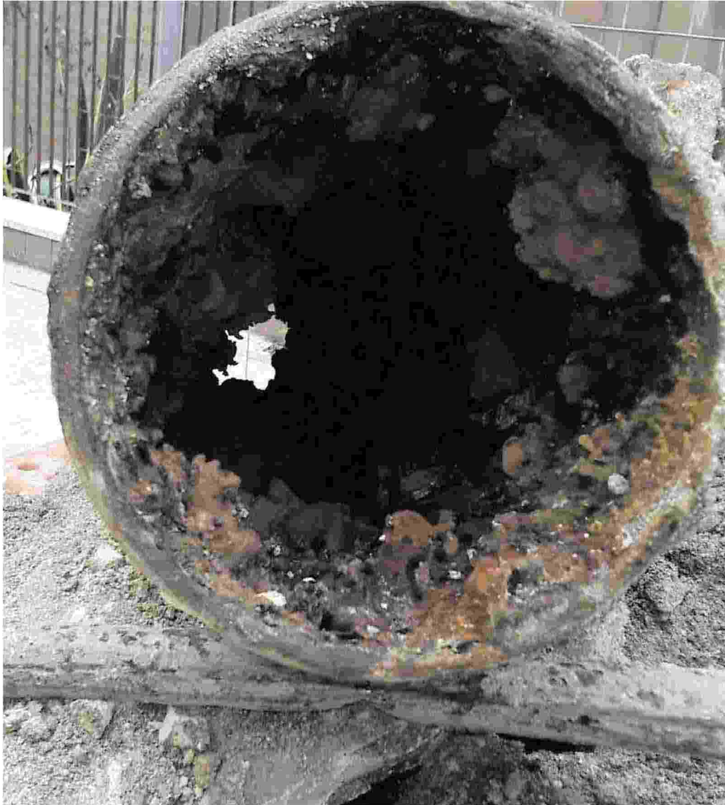
Una vecchia condotta sostituita da Abbanoa a Sassari
