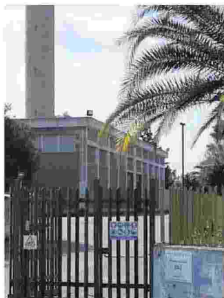
L'impianto di Abbanoa a Sili
