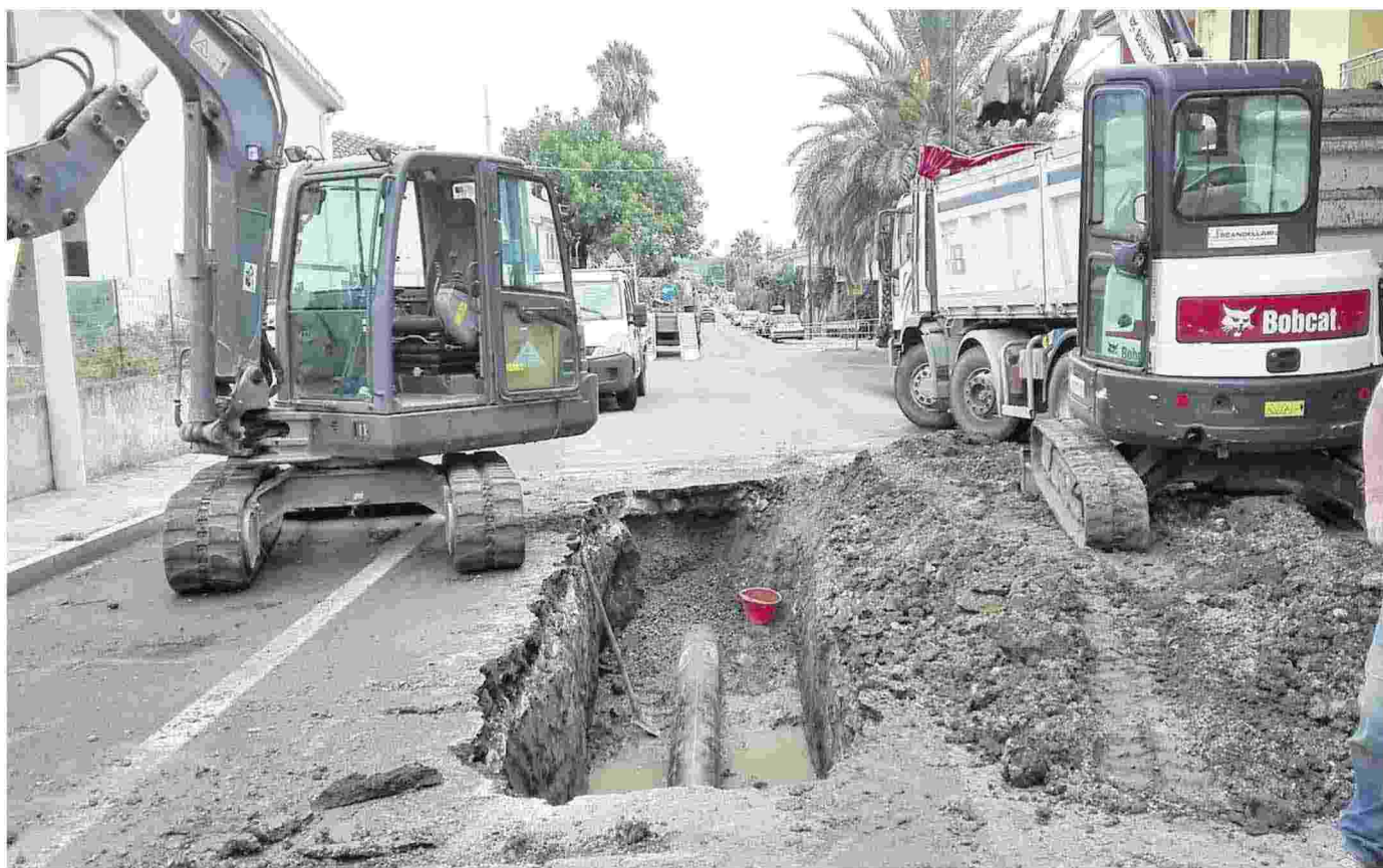
Lavori degli operai di Abbanoa nella rete idrica cittadina (foto Secci)
