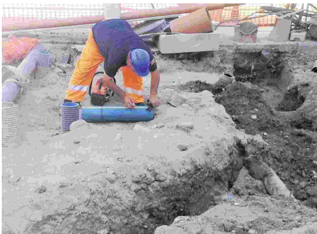
Lavori alla rete idrica
